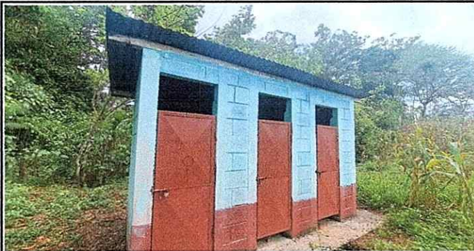
FOTO 5 Se colocaran las costaneras del techo de los sanitarios.
