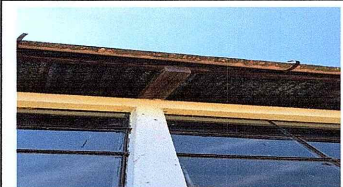
FOTO 3: Se cambian canales y baja de agua pluvial.
