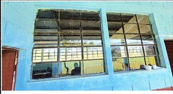
FOTO 4: Se colocarán los balcones de las ventanas del establecimiento.
